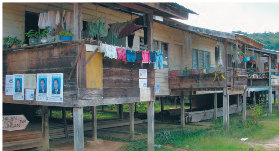
Ein typisches Langhaus auf Pfählen – wie es für diese Region üblich ist.
